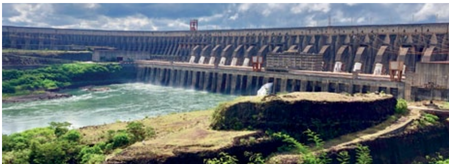
Das Wasserkraftwerk Itaipu ist mit einer Kapazität von 12.600 MW das zweitgrößte weltweit. Künftig will Brasilien verstärkt auf Wind- und Sonnenenergie setzen.
